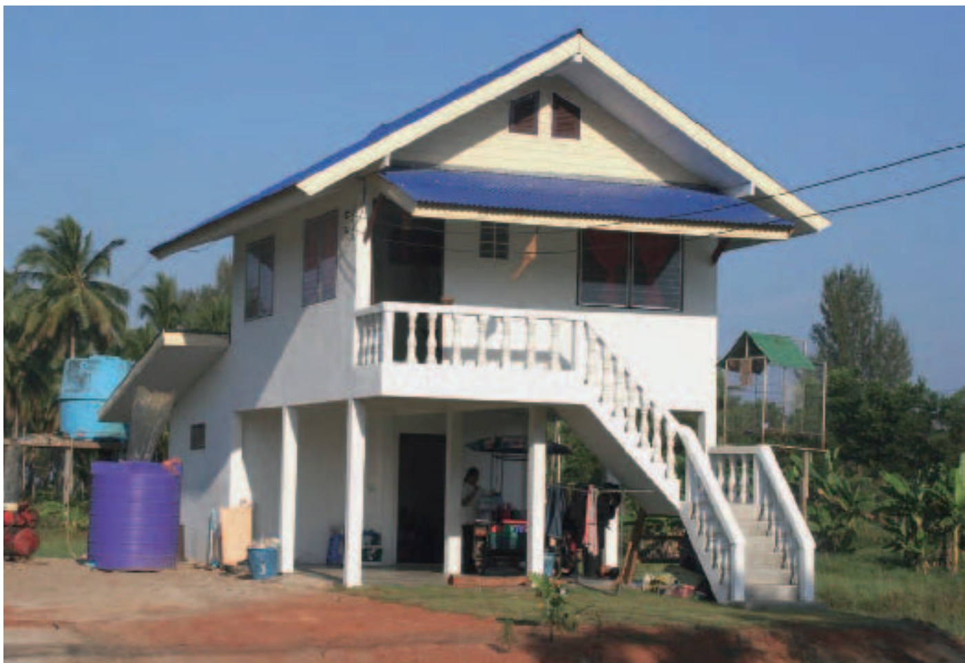
Bauen mit Risikobewusstsein: Die neu errichteten Gebäude im Tsunamigebiet um Khao Lak, Thailand, stehen auf Stelzen. So ist es den Bewohnern möglich, sich bei Flutwarnung in Sicherheit zu bringen. Die Maßnahme wirkt nachhaltig, wenn die Bauregeln eingehalten werden.
